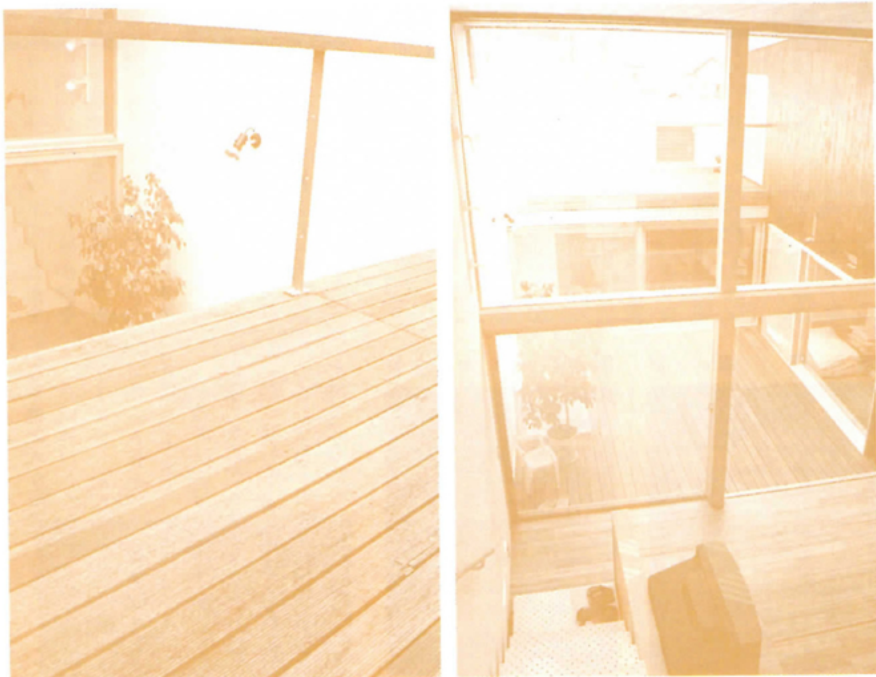
写真1 竹フローリングを施工したリビングとケンパスの光庭。写真奥の屋上も同じくケンパスを施工
